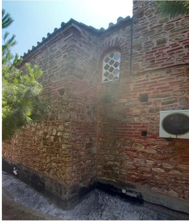
Resim 9: Hagios Stephones Kilisesi ( Fatih Camii ) dış duvarları
