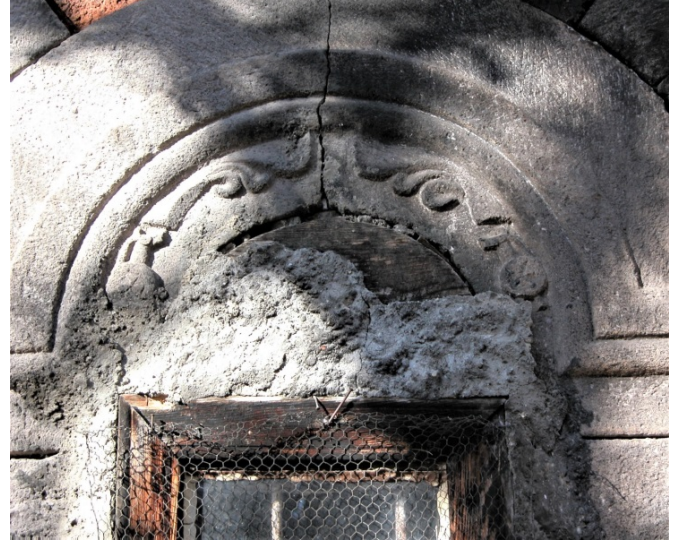
Fig. 53. Hahuli Kilisesi, doğu cephe, apsis penceresi
