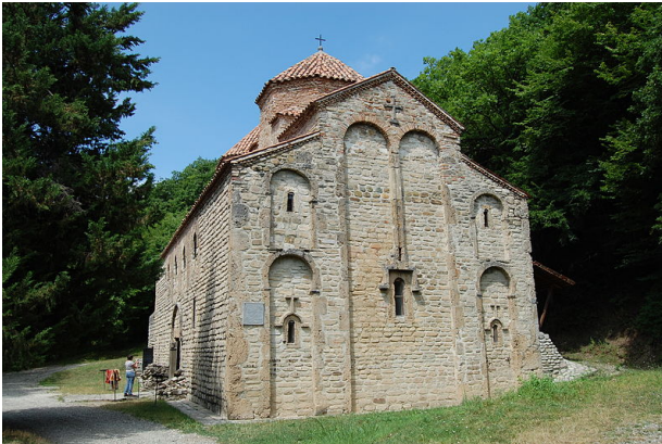
Fig. 3. Gurjaani Kvelatsminda Kilisesi, doğu cephe 170
