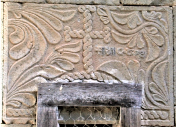
Fig. 54. Parhali Kilisesi, batı cephe, güneydeki pencere
