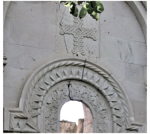
Fig. 21. İřhane Kilisesi, doğu cephe, merkezdeki kemerin alınlığı
