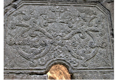
Fig. 64. İşhani Kilisesi, doğu cephe, kuzey uçtaki pencere
