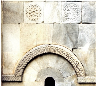
Fig. 14. Parhali Kilisesi, doğu cephe, prothesis mekanının alt katına açılan mazgal pencere
