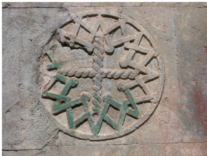
Fig. 16. Parhali Kilisesi, güney cephe
