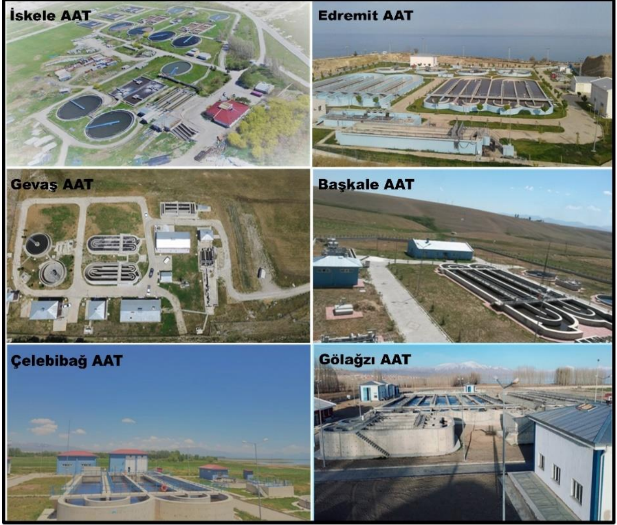
Şekil 2. Van İli evsel atıksu arıtma tesislerine ait görüntüler [27]
