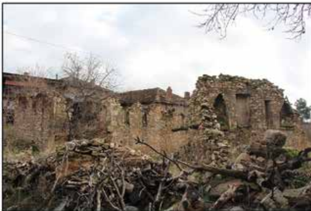
Fotoğraf 16: Zemin Kat Duvarları / Ground Floor Walls
