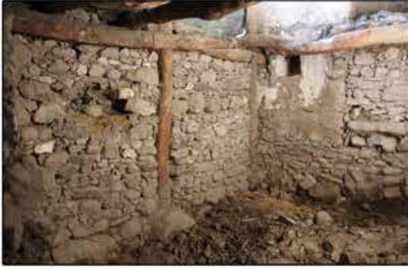
Fotoğraf 31: Ahşap Direklerle Desteklenen Duvar / Wall Supported by Wooden Pillars
