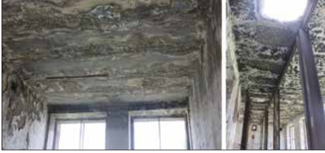
Fotoğraf 10: I profilli ve beton dolgulu tavan döşemesi / Concrete filled ceiling with I profiles
