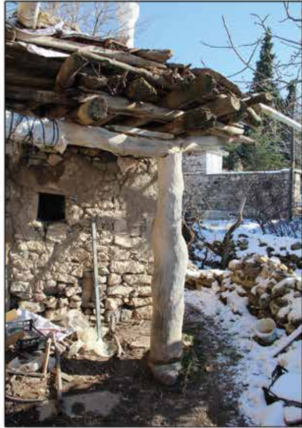
Fotoğraf 34: Taş Üzerine Oturtulan Ahşap Dikme / Wooden Pillars Sitting on Stone
