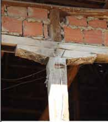
Fotoğraf 78: Ahşap Dikme Detayı / Wooden Pillar Detail
