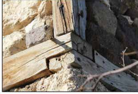
Fotoğraf 46: Kurt Boğazı Tekniği / Wolfthroat Technique
