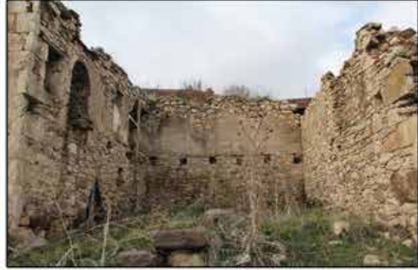
Fotoğraf 19: Zemin ve Üst Kat Cepheleri / Ground and Upper Floor Facades
