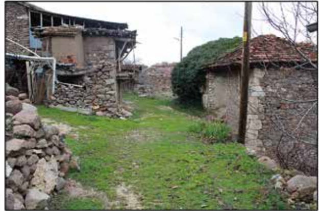
Fotoğraf 15: Zemin Kat Duvarları / Ground Floor Walls
