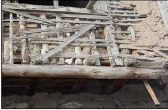
Fotoğraf 49: Çamur Harçla Sıvalı Bağdadi Çita / Mud Mortar Plastered Baghdadli Lath
