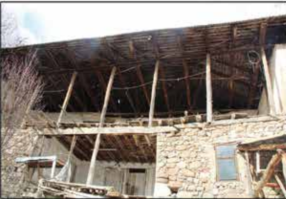
Fotoğraf 59: Çatı / Roof
