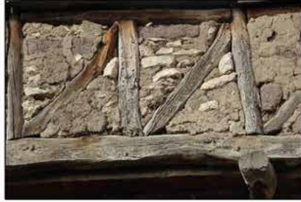
Fotoğraf 48: Taş, Kerpiç, Tuğla Dolgu Malzemeleri / Stone, Adobe, Brick Filling Materials
