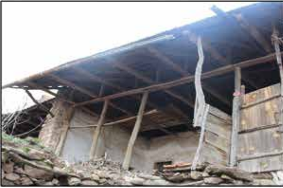
Fotoğraf 55: Odalardan Uzayan Ahşap Kirişler / Wooden Beams Extending from Rooms
