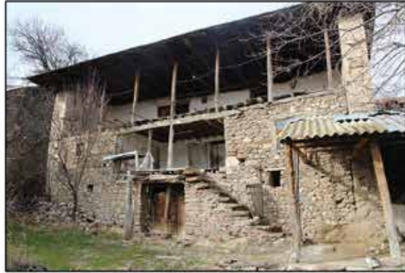
Fotoğraf 6: Güney Cephesi - Sofa / South Facade - Sofa
