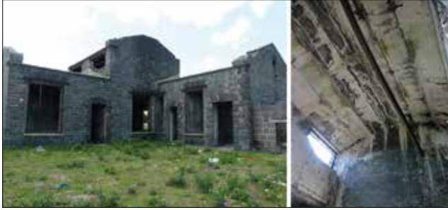
Fotoğraf 11: 105 no'lu mekanın üzerini örten beton dolgulu, çelik kirişli tonoz / Concrete filled and steel beam vault of the room 105
