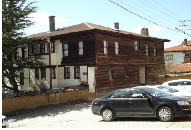
Resim 4. Çarıkçılar Konağı - Ahşap Cephe Kaplama Örneği (Kişisel Arşiv- 20.09.2017)
