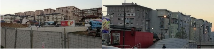
Şekil 23. Savaş sonrası konut yapıları ve yeni inşaatlar (Bilgili, 2018).
