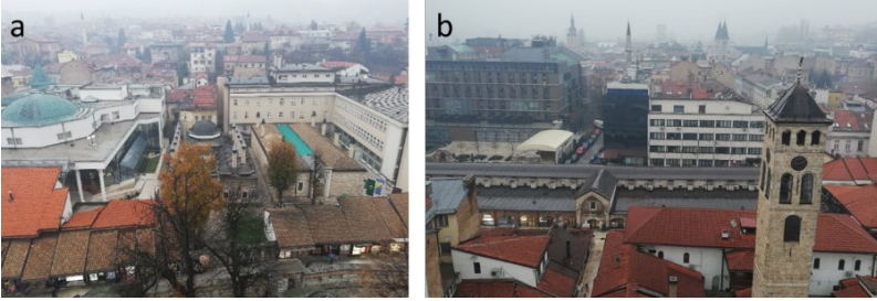
Şekil 25. Hüsrev Bey Camii'nden Başçarşı'ya bakış; a) Bir grup yapının yıkılıp yerine Katar'ın desteğiyle inşa edilen Hüsrev Bey Kütüphanesi, çarşı yapıları (Bilgili, 2018); b) Önde Saat kulesi ve Taşhan; arkada Hilton otel ve dini yapıların kuleleri (Bilgili, 2018).
