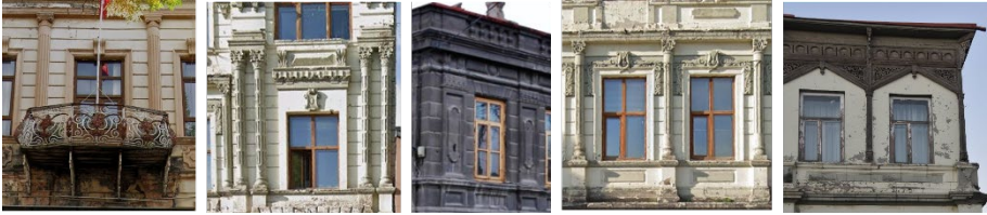
Şekil 8. İncelenen binaların figüratif öğe detayları (Kaynak: Google Earth, 2021; Türkan, 2017, s.94, 156)
