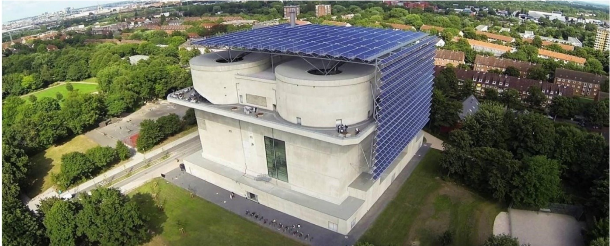
Resim 13: Energie Bunker binası ( https://www.welt.de/regionales/hamburg/article194210695/Geothermie-Hamburg-setzt-auf-Waerme-aus-der-Tiefe.html#cs-Energiebunker-Wilhelmsburg-Hamburg-Ener.jpg )
