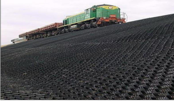
Şekil 2. Demiryollarında Geocell kullanımı (Tarsu, 2021)
