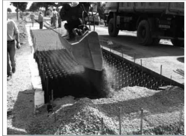
Şekil 3. Asfaltsız yollarda Geocell takviyesinin uygulanması (Emersleben vd., 2008)
