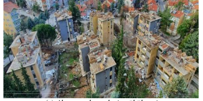
(c) Ahşap malzemelerin sökülmesi
