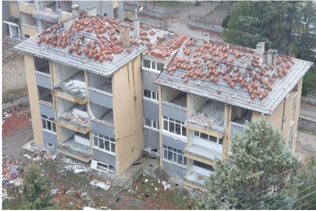
(a) Çatı kaplamasının sökülmesi
