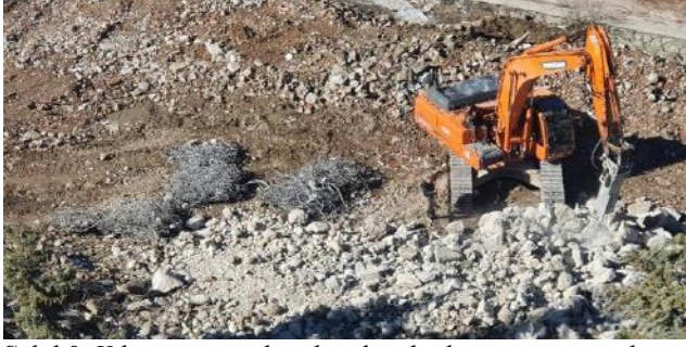
Şekil 9. Yıkım esnasında çıkan hurda demirin ayrıştırılması
