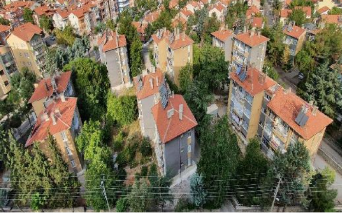
Şekil 6. Yıkımı işlemi gerçekleştirilecek binalar
