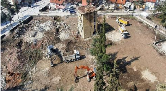
Şekil 10. Yıkıntı atıklarının yıkım alanından uzaklaştırılması
