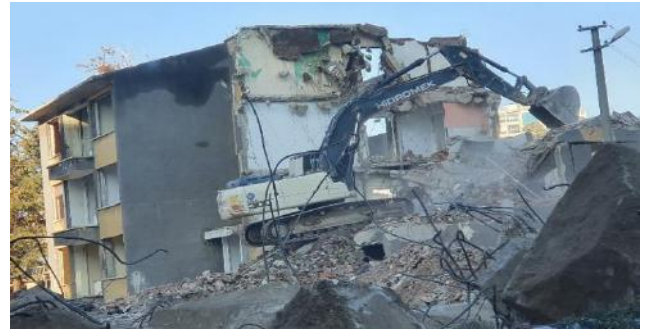
(a) Yıkımı yapılan bina
