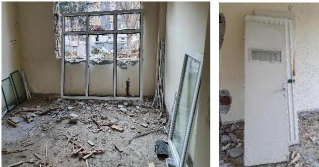
(b) Kapı ve pencerelerin sökülmesi
