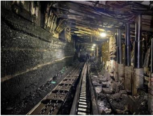
Resim 1. GLİ yeraltı üretim tesisi
