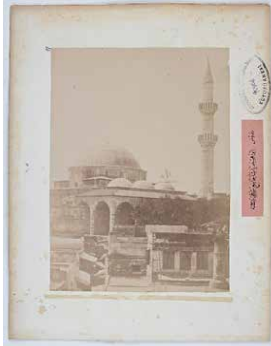
G. 15: İbrahim Paşa Camii (N.E.K. Arş. No. 90806-0011).
