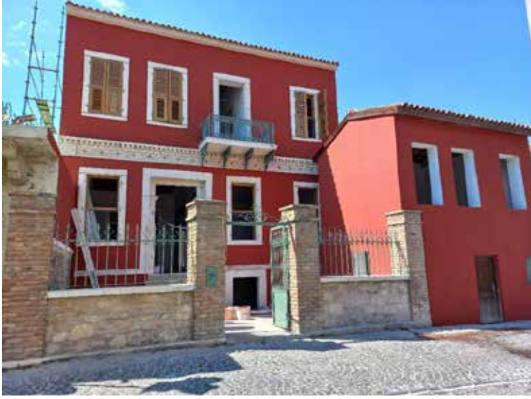
G. 2: Manol Evi Alay Sokağa bakan cephe. Restorasyon süreci (Söke Belediyesi Arşivi, 2021)
