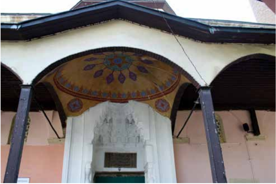
G. 8: Taç kapı üzerine hatalı bir şekilde yerleştirilen orta kubbe (F. Koçyiğit, 2020)
