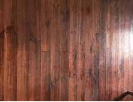
F. 25.a: Başoda’s Ceiling of Küçük Mehmet Build. (Koşanlar, 2018)
