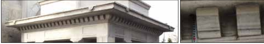
G. 7: Saçak ve Konsollardan Detay (M. Bulut, 2015).
