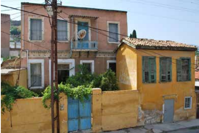
G. 1: Manol Evi, Alay Sokağa bakan cephe. Restorasyon öncesi. (Söke Belediyesi Arşivi, 2010)
