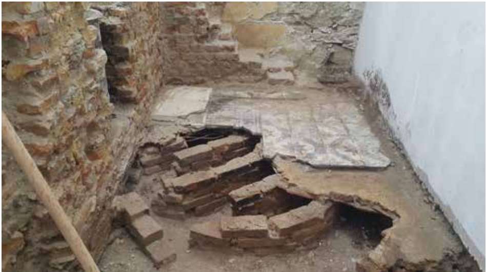
G. 6: Manol Evi hamamı zemin, ısıtma sistemi (Söke Belediyesi Arşivi, 2020)
