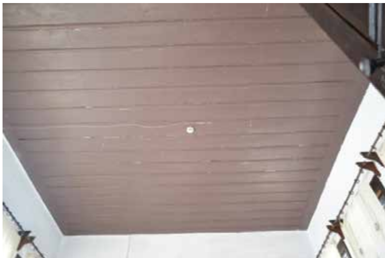
F. 10: Başoda's Ceiling of Eaved House (Koşanlar, 2018)
