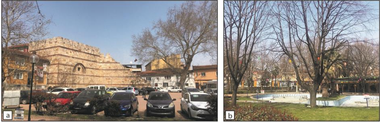
Şekil 7. Pınarbaşı Meydanı ve Fetih Kapısı (a). Pınarbaşı Parkı'nda bulunan kafe ve süs havuzu (b).
