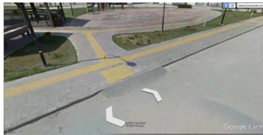
Şekil 19. Park Girişindeki Kaldırım Rampası
