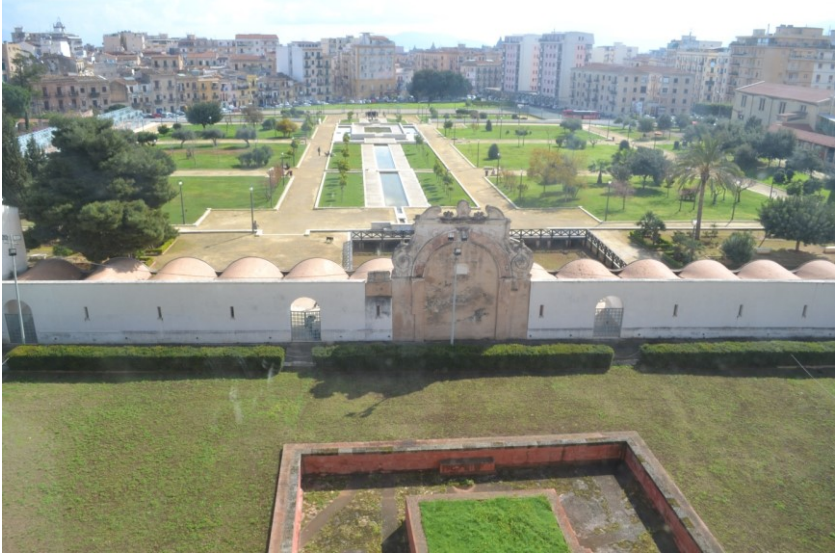
Castello de Zisa'nın Havuzlu Bahçesi
