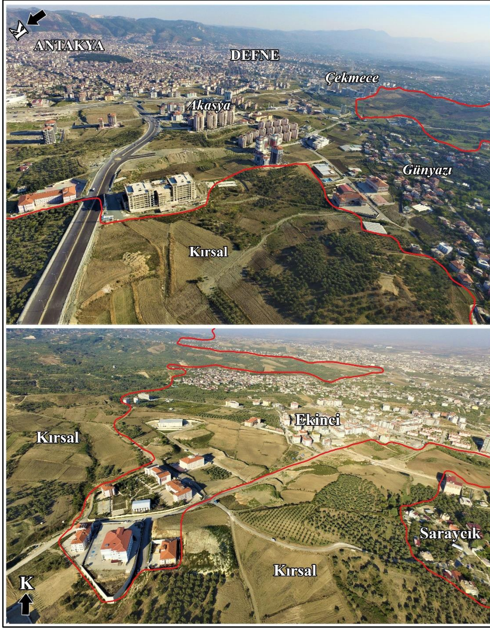
Foto 2. Antakya kentsel alanının batı sınırları
