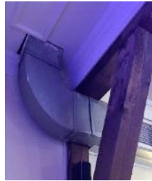
Şekil 34: Bodrum Kat Seminer Odası Hava Kanalı Görünüşü
