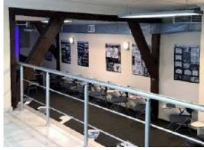
Şekil 32: Bodrum Kat Seminer Odası Hava Kanalı Görünüşü
