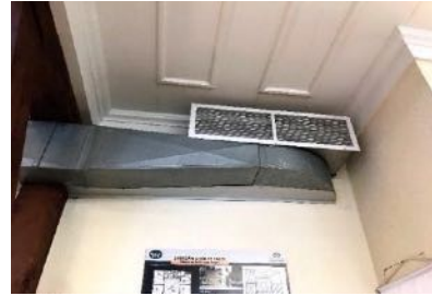
Şekil 35: Bodrum Kat Seminer Odası Hava Kanalı Görünüşü
