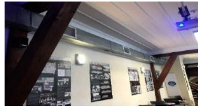
Şekil 33: Bodrum Kat Seminer Odası Hava Kanalı Görünüşü
