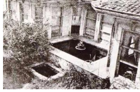
Şekil 17: Mermer Havuzun Restorasyon Öncesi Görünüşü
