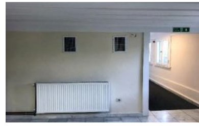
Şekil 45: Bodrum Kat Bekleme Salonu Duvardan Kanal Çıkışı
