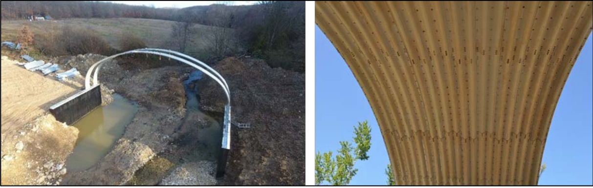
Şekil 7. Galvanizli körüğe çelikten çelik köprü taşıyıcı elamanların hazırlanması
