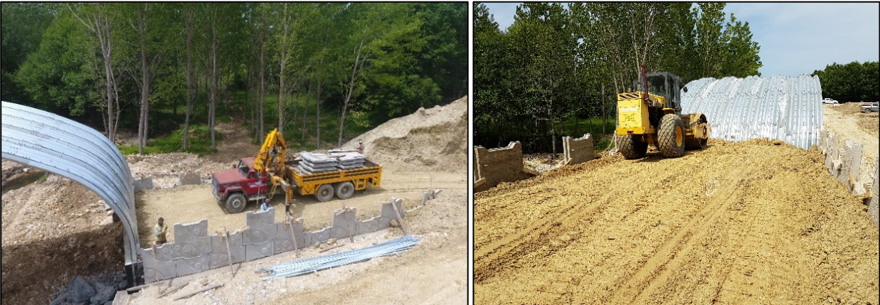
Şekil 9. Toprakarme için prekast cephe panellerinin ve köprü yaklaşım dolguları için hazırlanması
