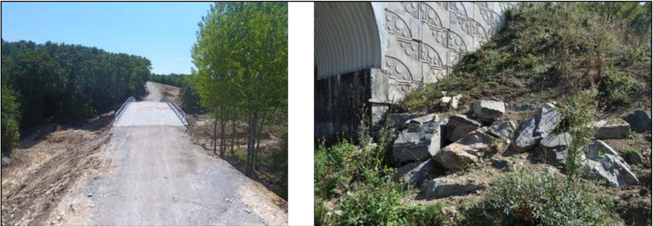
Şekil 11. Köprü yaklaşım dolgusunun ve taş blokajların hazırlanması
