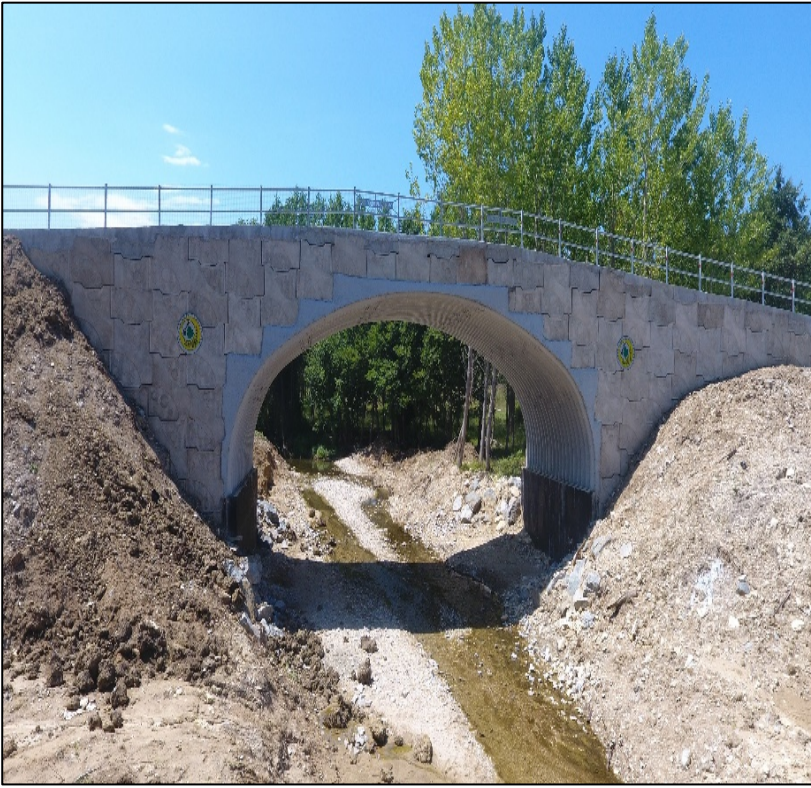
Şekil 13. Çelik köprünün mevcut durumu
