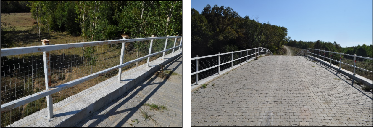
Şekil 10. Çelik köprü korkulukları ve kilit taşı malzeme ile köprü üst yapısının oluşturulması
