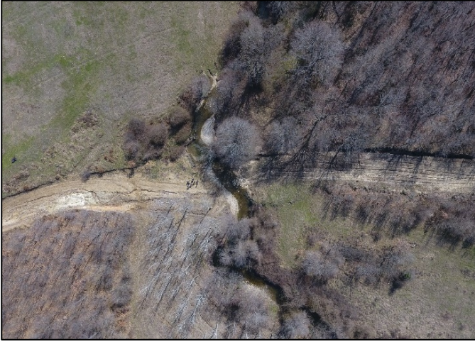
Şekil 3. Çelik köprü yapım yerinin inşaat öncesi görüntüsü
