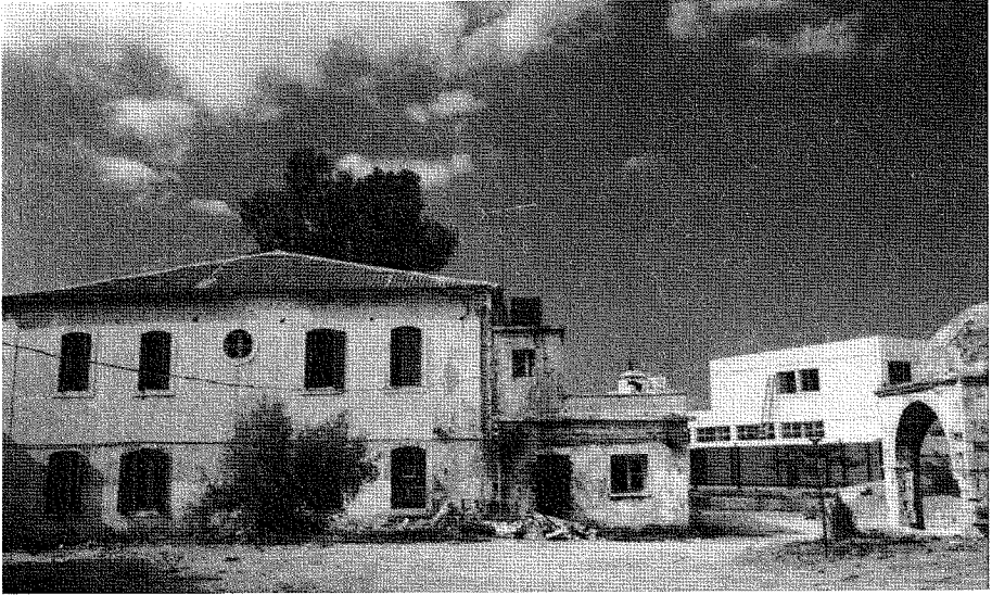
16. Semahânenin bugünkü halini gösteren kible tarafından çekilmiş bir fotoğraf. Sağdaki bitişik bina türbe. En sağdaki müstakil türbe ise kime ait olduğu tesbit edilemeyen tekkeye vakıfta bulunan zevattan birinin türbesi. Şu anda bomboş halde duran alan mevlevihânenin haziresi alanıdır.
