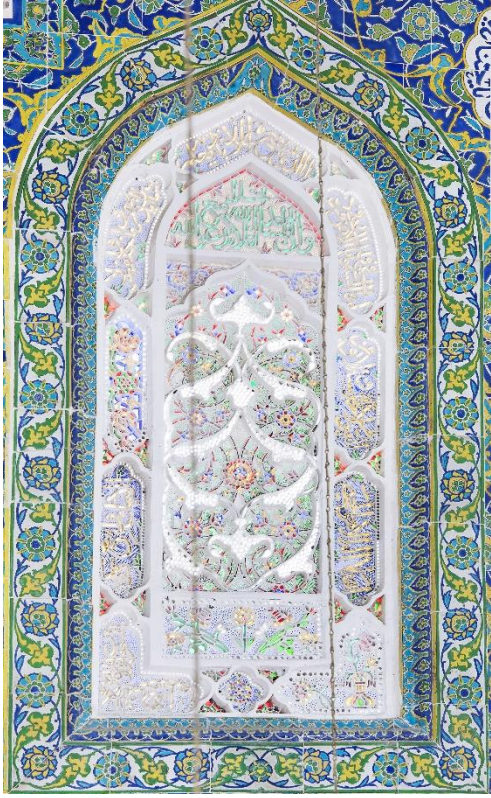
Fotograf 9: Batı Duvarı Sol Pencere
