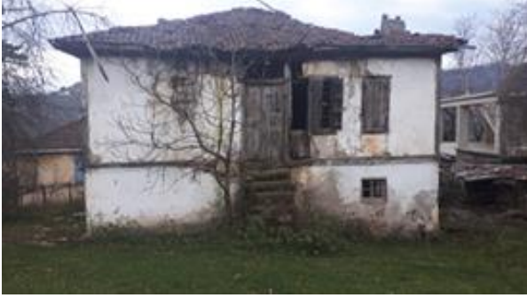
Görsel 3. Kuzey Cephe.
