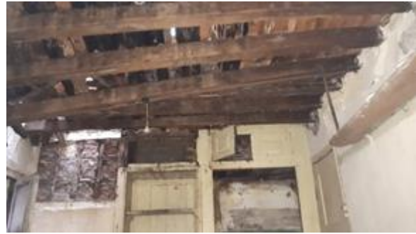
Görsel 13. Zemin Kat Mutfak Tavanı.
