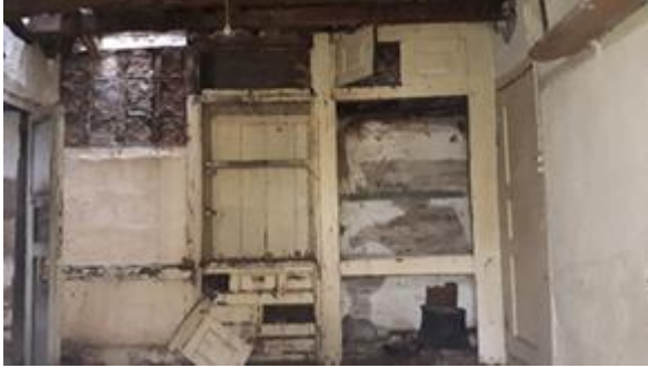
Görsel 12. Zemin Kat Mutfak Batı Duvarı.
