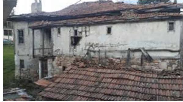
Görsel 4. Batı Cephe.
