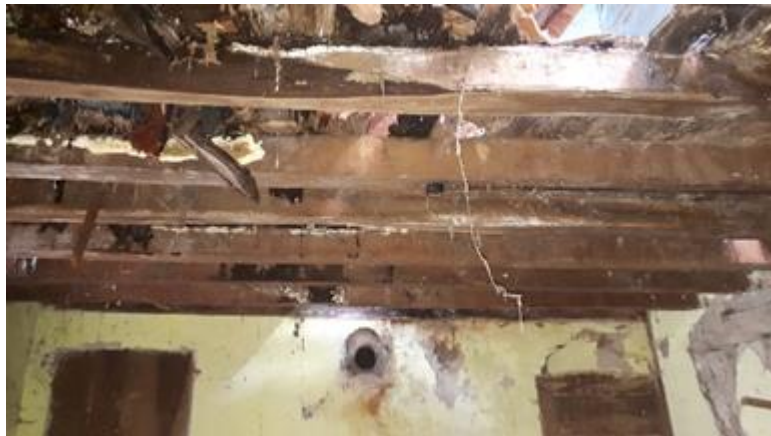
Görsel 19. Güneybatı Odanın Tavanı.
