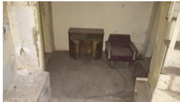
Görsel 10. Zemin Kat Sofası Zemini.
