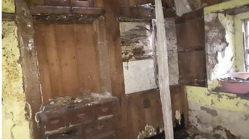
Görsel 17. Zemin Kat Güneybatı Odanın Doğu Duvarı.
