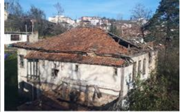
Görsel 6. Güneydoğu Yönden Çatı.
