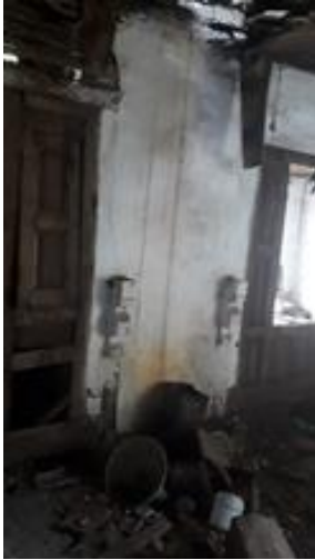
Görsel 26. Birinci Kat Kapatılmış Ocak.
