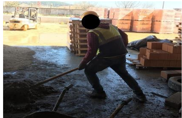
Şekil 4. Harç Hazırlama İşlemi
