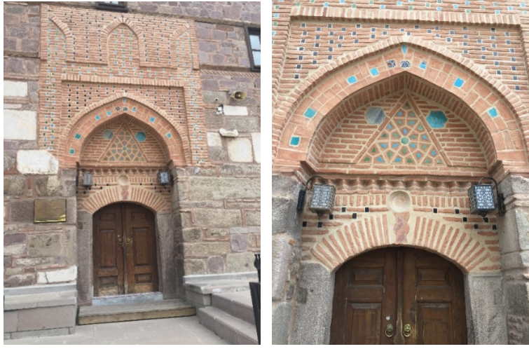
Resim 3. Arslanhane Cami Batı Kapısı
