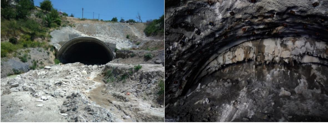
Şekil 6. T7 Tüneli giriş portal kesimi ve tünel aynası
