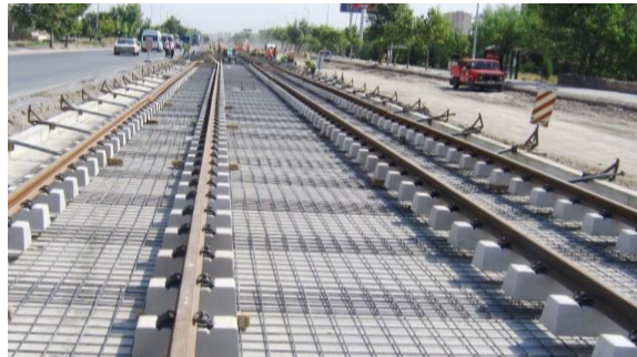
Şekil 1. Ray mesnet blokları traverler
