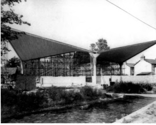
Şekil 3. The Wilton Carpet Factory Hiperbolik Parabol Kabuk Çatısı [12]
