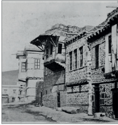
Erzurum Evinde Payandalı (Gögüşleme, Eliböğründel) Cumba Çıkması
