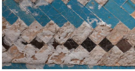
Resim 26. Konya Sahip Ata Hankahı, sır yüzeyinde tuzlanma-çiçeklenme
