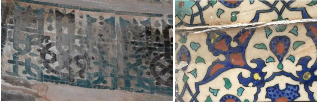
Resim 33. Akşehir Taş Mescit, onarıma ait leke-kirlilik (Solda).
