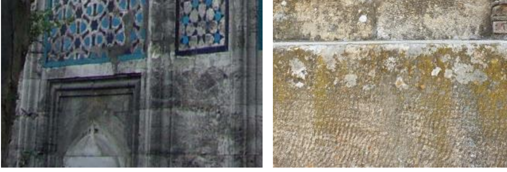
Resim 7. İstanbul Mahmut Paşa Türbesi, taşıyıcı duvarlarda yüzeysel kirlilik (Solda) (Taşkiran, 2014: 76).
