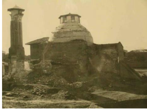
Resim 1. Batman Zeynel Bey Türbesi, Taşıyıcı Duvarlarda Yarılma-Ayrılma (Solda) (Eskici vd., 2008: 25).
