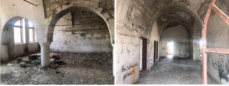
Şekil 9. Hasaköy Sasima Rum Okulu'nun taşıyıcı sistemi (Yazar, 2020)
