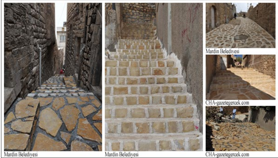
Şekil 7. Mardin Tarihi Dönüşüm Projesi kapsamında yapılan sokak yenileme çalışmaları (Sol ve orta resimler: Mardin Belediyesi, 2012a; Sağ-üst resim: Mardin Belediyesi, 2012b; Sağ orta ve alt resimler: Cihan Haber Ajansı [CHA], 2011)
