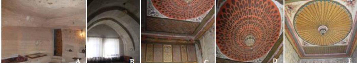
Fotoğraf 23: Konut Tavan Örnekleri, A.Düz Tavan Yüzeyi, Aydınli Mh. Aydınli Sk. No: 12, B.Tonoz Tavan Yüzeyi, Aydınli Mh. İsalı Cd. No: 36, C.D.E.Tillioğulları Evi Baş Oda ve Yanındaki Oda Duvar ve Tavanında Ahşap (Göbek) Kullanımı, Orta Mh. Konak Sk. No: 14A (F.Toruk Arşivi)
