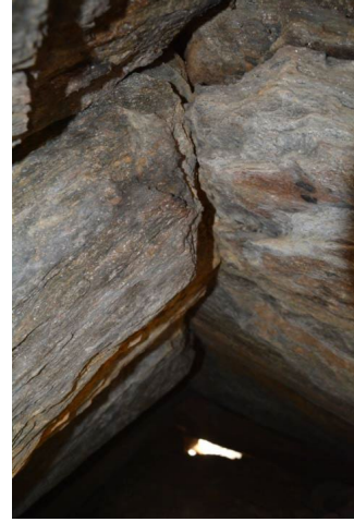
Figür 18. Beşik çatıyı oluşturan taşların çapraz kesim birleşme yerleri
