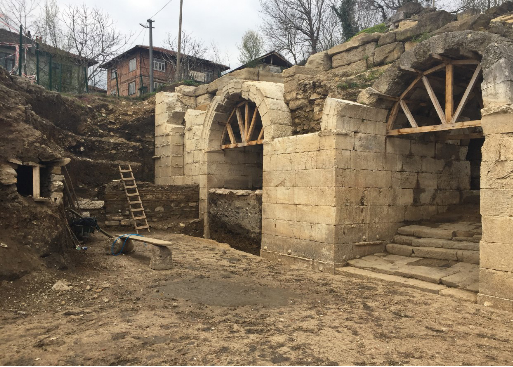
Fig. 3. Batı analemma ve oturma basamaklarına ulaşımı saęlayan vomitoria.
