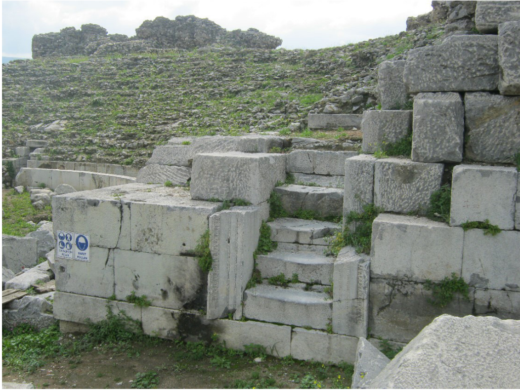
Fig. 17. Nikaia tiyatrosu, batı tribunale ulaşımı sağlayan merdiven.
