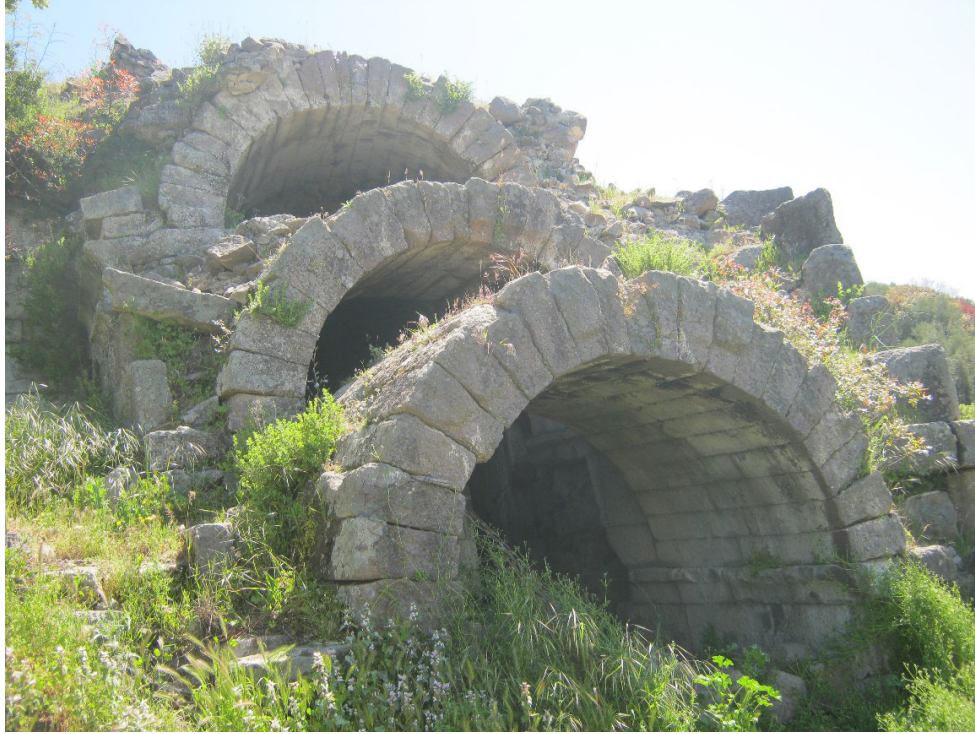
Fig. 14. Aigai tiyatrosu, vomitoriumda basamaklı beşik tonoz kullanımı.
