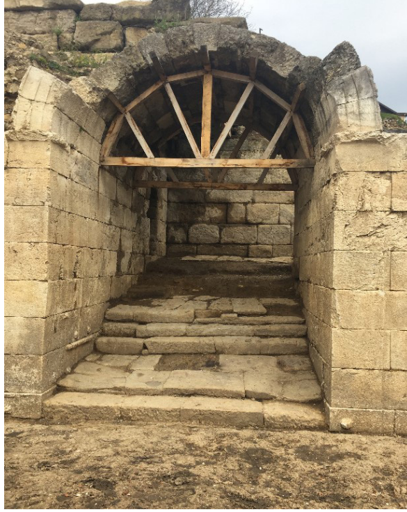
Fig. 7. Batı analemma, media cavea giriřinde tonoz kullanımı.
