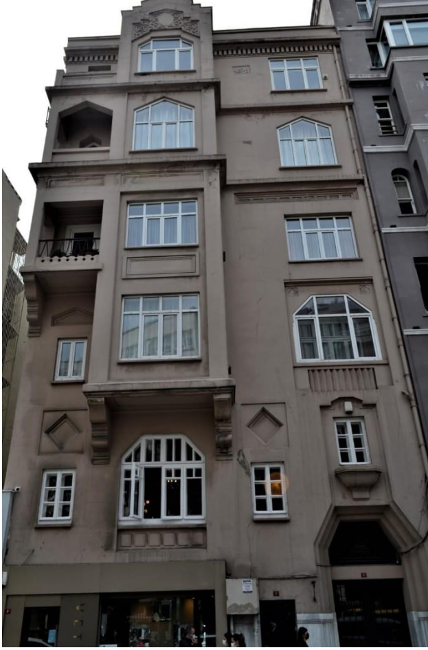
Fotoğraf 38: Güneş Apartmanı genel görünüm (twitter)
