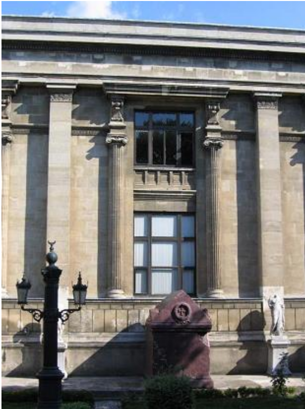
Fotoğraf 6: Müze-i Hümayun Girişin yanlarındaki pilasterler (Kılıç, 2006 s.99)
