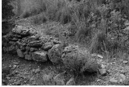
Fig. 7 Olucak Dere Vadisi. Yol istinat duvarları.
