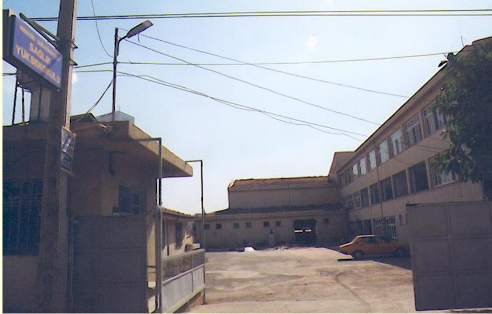
Şekil 4. İçel Sağlık Yüksekokulu Binası, Akdeniz/Mersin
