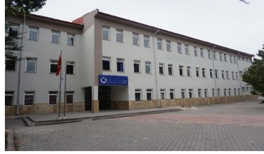
Şekil 6. Yapım Yılı 2002'den Önce Olan 4. Bina
