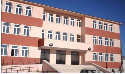
Şekil 5. Yapım Yılı 2002'den Önce Olan 3. Bina
