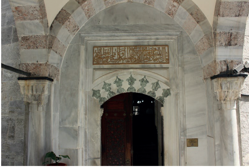
Fotoğraf 3. Siyavuş Paşa Türbesi girişi âyet kitâbesi.
