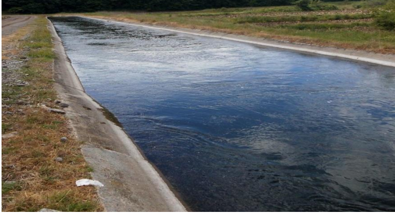
Şekil 1. Türbin tasarımının denendiği ve hesaplamaların yapıldığı Balıkesir/Gönen tarımsal sulama kanalı
