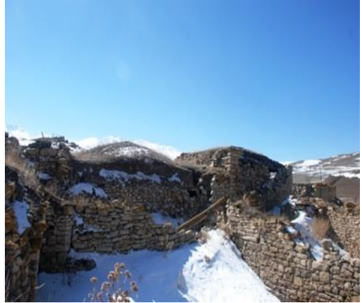
Şekil 10. Yapının kuzeyden dış görünümü
