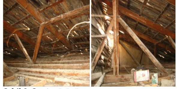
Şekil 9. Çatı iç görünüş
