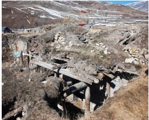
Şekil 11. Yapının güneydoğudan dış görünümü
