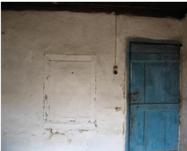
Şekil 13. 102 no'lu odaya ait duvar nişi.
