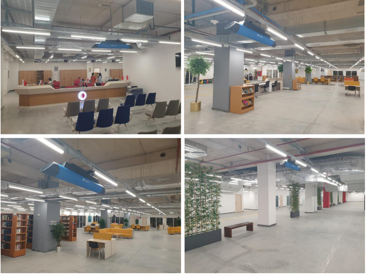
Şekil 12: UV-C Tüp Sistemlerinin Yerleşkenin koridor ve toplantı salonlarına takılması işlemleri.
