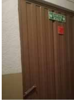
Şekil 18. Yangın merdiveni kapısı (Kişisel Arşiv)
