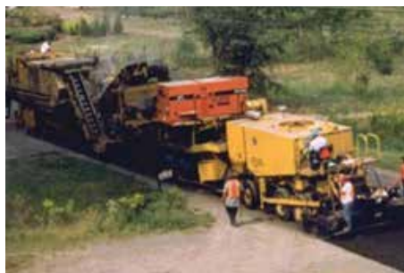
Şekil 3. Soğuk geri dönüşüm (Kuyucu, 2019)
