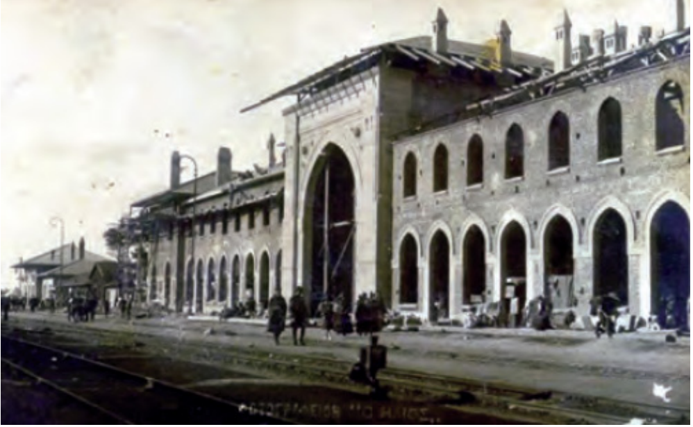
Foto. 13: Edirne-Karaağaç Gar Binası (Trakya Üniversitesi Güzel Sanatlar Fakültesi), Eski Peron Cephesi Görünümü, 1910'lu yıllar
