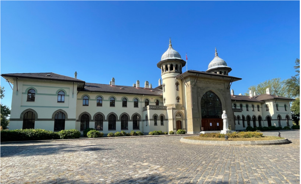
Foto. 14: Edirne-Karaağaç Gar Binası (Trakya Üniversitesi Güzel Sanatlar Fakültesi), Ön Cepheden Görünüm
