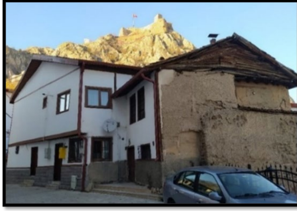
Şekil 8. Tokat Halit Sokak'ta bir yapının yola cephe vermeyen arka cephesinin görünümü (1. yazarın arşivinden)
