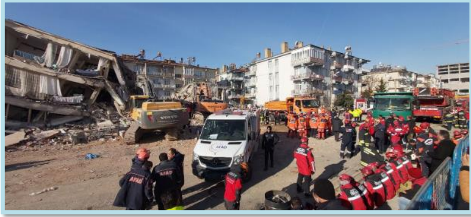
Şekil 1. Elazığ merkez Sürsürü Mahallesinde çöken binadaki enkaz kaldırma çalışmasına ait görüntü. (TMMOB;2020)
