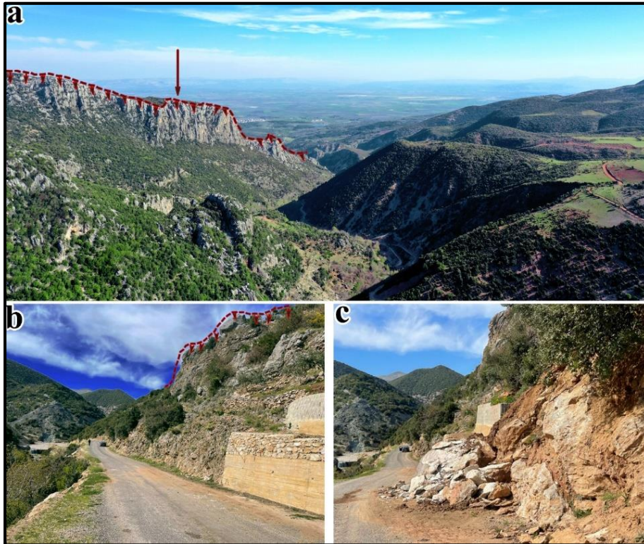
Fotoğraf 4- Düşme tipi heyelan riskinin yüksek olduğu sahalarda drone görüntüsü (a) ve bu sahalara yönelik inşa edilen istinat duvarları (b-c) (Oklar kaya düşmelerinin fazla olduğu alanları göstermektedir)
