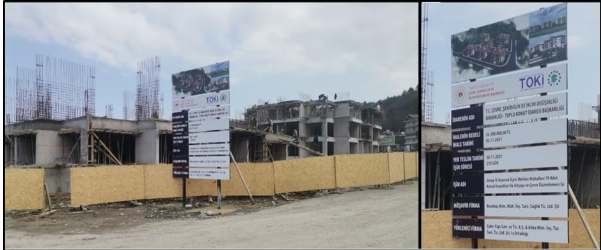
Foto 9- Ayancık ilçe merkezinde inşaatı devam eden afet konutları.
