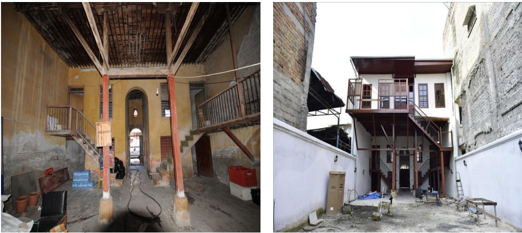
Şekil 12. 152 no.lu Envanter iç bölüm ön cephe eski ve yeni hali (KUDEB, 2016)
