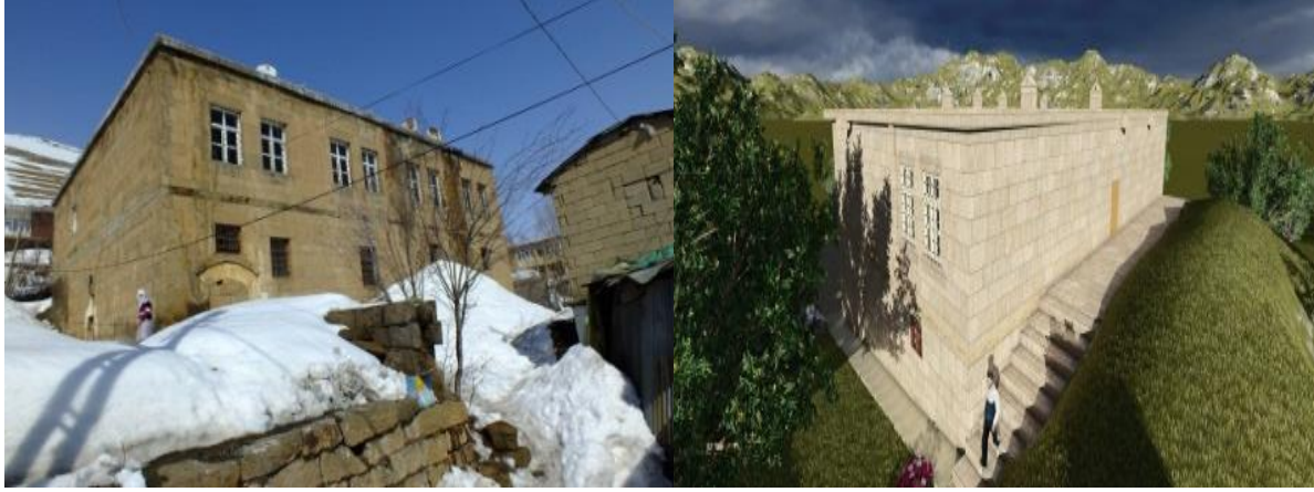
Res. 27, 28: Fikri Kızılkaya Evi Güneybatı ve Güneydoğu Görünüşleri (Ş. Öztürk)
