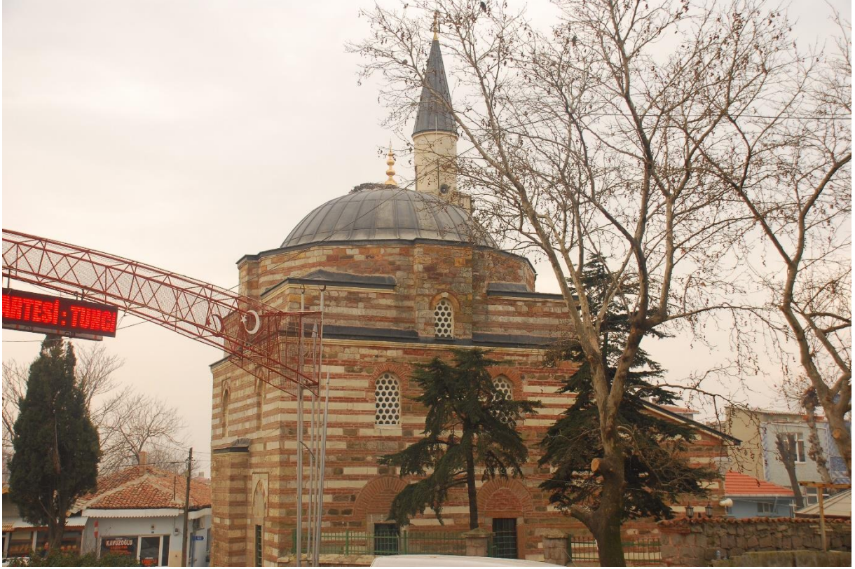
Res. 10: Alaca Mustafa Paşa Camii doğu cephesi
