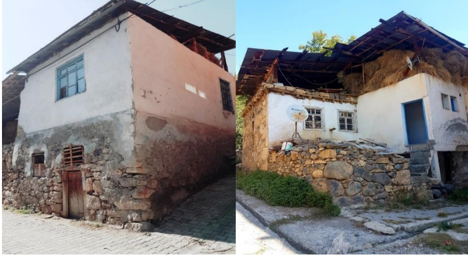
Fotoğraf 3.16. Şenyurt Mahallesinde Birinci Katında Ahır Bulunun Meskenlerden Görünümler
