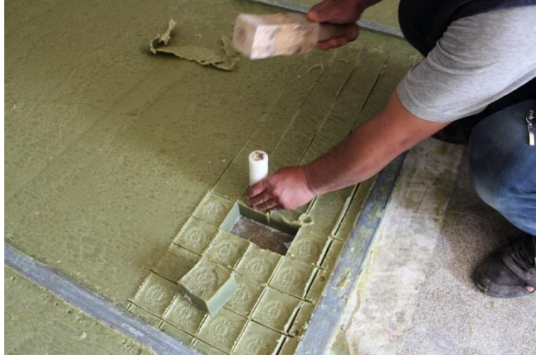
Kaynak: M. Çiftyürek
