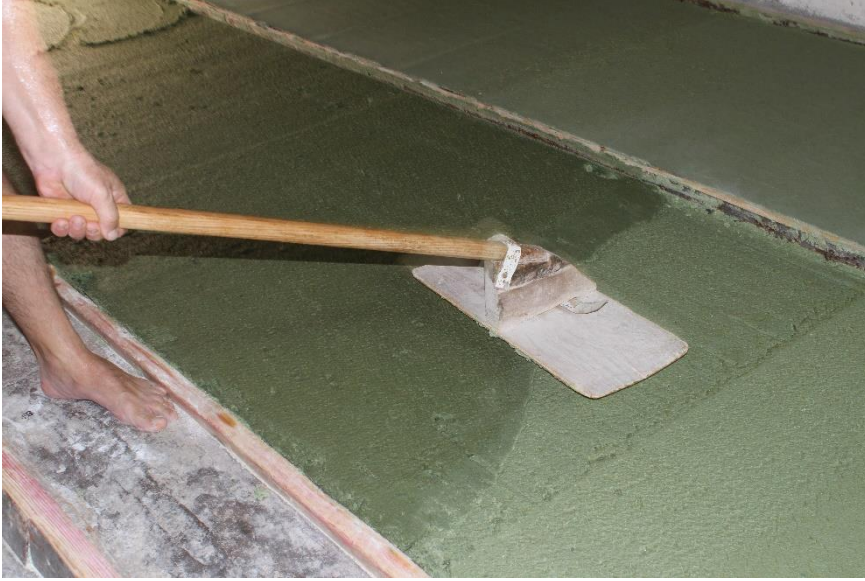
Kaynak: M. Çiftyürek
