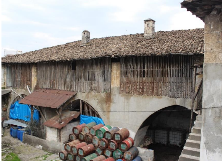
Şekil 4: Kuseyri Sabunhanesi'nin Avluya Bakan Batı Cephesi
