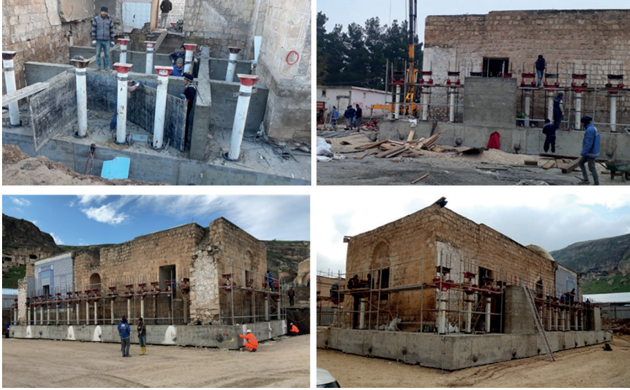
Görsel 16: Kızlar (Eyyubi) Camii Batı ve Doğu Bloğu Strüktürel Bütüncül Taşıma Projesi Kaldırma Kriko Sisteminin Kurulması (KVMGM ve DSİ arşivi).
