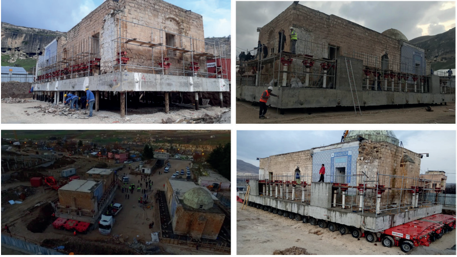
Görsel 17: Kızlar (Eyyubi) Camii Batı ve Doğu Bloğu Strüktürel Bütüncül Taşıma Projesi Kaldırma Kriko Sistemiyle Kaldırılması ve SPTM taşıyıcı platform üzerine Alınması (KVMGM ve DSİ arşivi).
