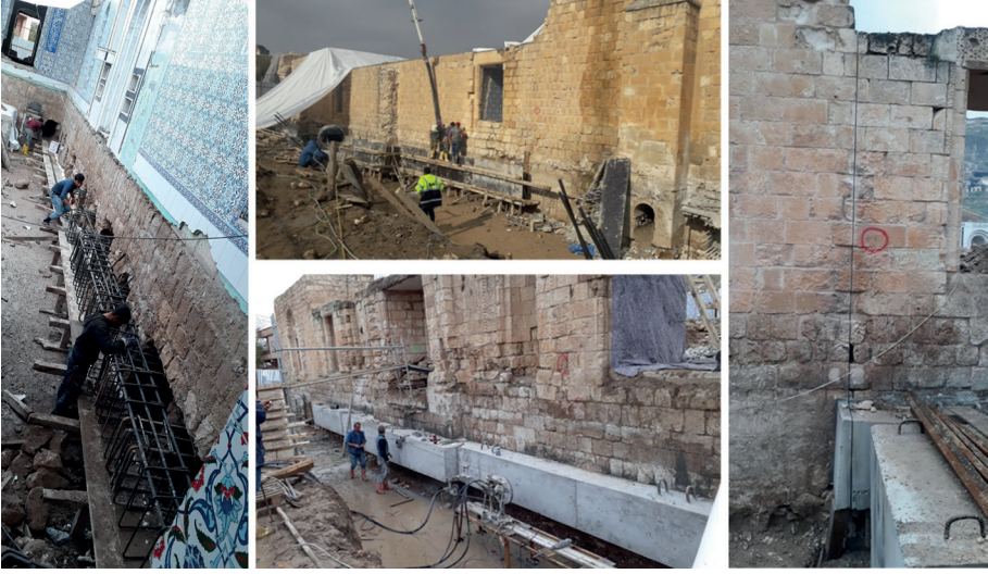
Görsel 11: Kızlar (Eyyübi) Camii, Avlusunun Güneyinde ve Kuzeyinde Yer Alan Alçak Seviyeli Duvarlarının 3'er Bloğa Ayrılarak Taşıma çalışmaları (KVMGM ve DSİ arşivi).
