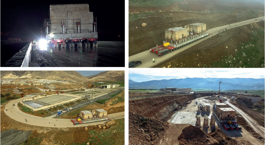
Görsel 18: Kızlar (Eyyubi) Camii Batı Bloğu Strüktürel Bütüncül Taşıma Projesi Kapsamında 24 Akslı 3 Sıradan (Toplam 72 Aks) Oluşan SPTM Taşıyıcı Platform Üzerinde Arkeopark Alanındaki Yeni Konumuna Taşınması (KVMGM ve DSİ arşivi).
