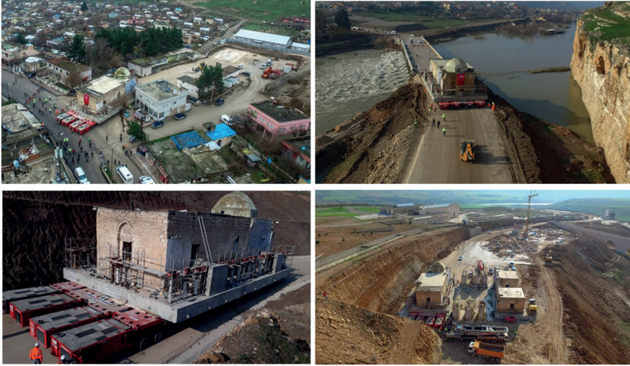
Görsel 19: Kızlar (Eyyubi) Camii Doğu Bloğu Strüktürel Bütüncül Taşıma Projesi kapsamında 22 akslı 4 sıradan (toplam 88 aks) Oluşan SPTM Taşıyıcı Platform Üzerinde Arkeopark Alanındaki Yeni Konumuna Taşınması (KVMGM ve DSİ arşivi).
