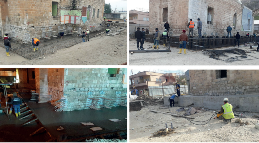
Görsel 14: Kızlar (Eyyubi) Camii Batı Bloğu Strüktürel Bütüncül Taşıma Projesi Betonarme Temel Zemini Platformu ve Betonarme Kaldırma Platformu İmalat Çalışmaları (KVMGM ve DSİ arşivi).
