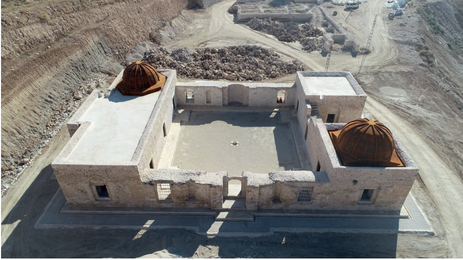
Görsel 20: Hasankeyf Kızlar (Eyyübi) Camiinin Arkeopark Alanındaki Yeni Konumunda Restorasyon ve Sergileme Çalışmaları Sonrası (KVMGM ve DSİ arşivi).
