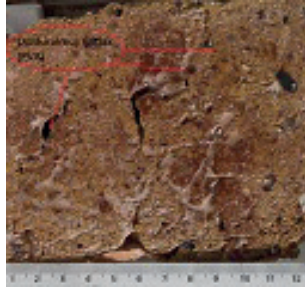
Görsel 16. Kerpiç Örnek Üzerinde İnce Çatlak ve Gözeneklerin Sağlamaştırılması
