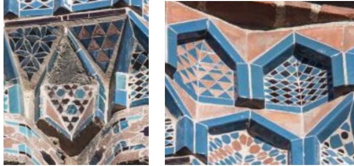
Foto. 19: Çifte Minareli Medrese, doğu minare mukarnas çinilerinde uygulanan çimento katkılı harç ile yapılan tamamlamalar (Solda).
