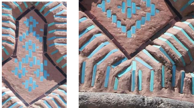
Foto. 21: Yakutiye Medresesi, minare gövde alçak zemin tuğlalarında uygulanan renklendirilmiş alçı ve kireç katkılı harç ile yapılan tamamlamalar (Solda).
