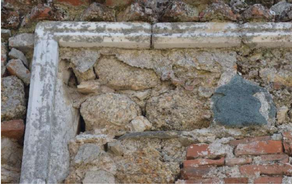
Resim 5: Türbe giriş kapısı üzerindeki çerçeve içinde Palmet kabartması
