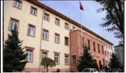
Foto. 44. Yozgat Hükümet Konağı (2017)
