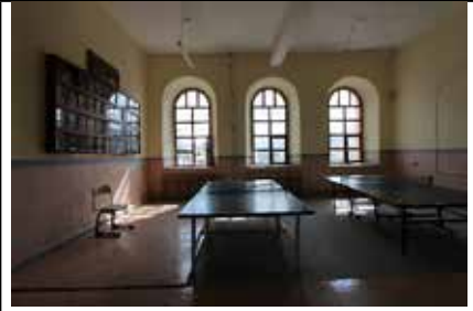
Foto. 24. Yozgat Lisesi Birinci Kat Koridor Pencereleeri (2017)
