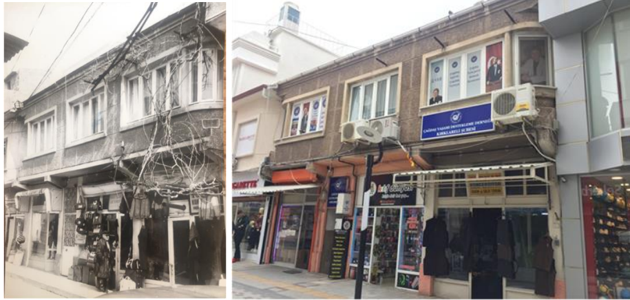
Şekil 10. Yapının ön cephesi 1987 ve 2020 yıllarına ait fotoğraflar
