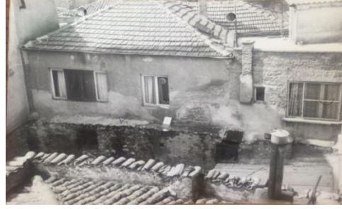
Şekil 11. Yapının arka cephesi 1987 ve 2020 yıllarına ait fotoğraflar
